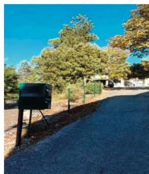
Pose d'un grillage de sécurisation
