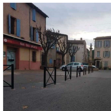
Pose de barrières de sécurité
