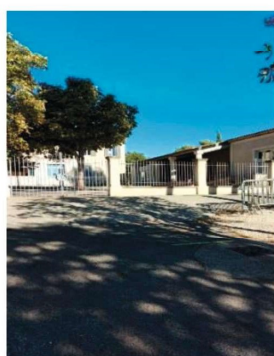
Peinture des grilles et du portail de l'école
