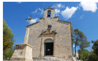
LES GRANDS CHANTIERS
